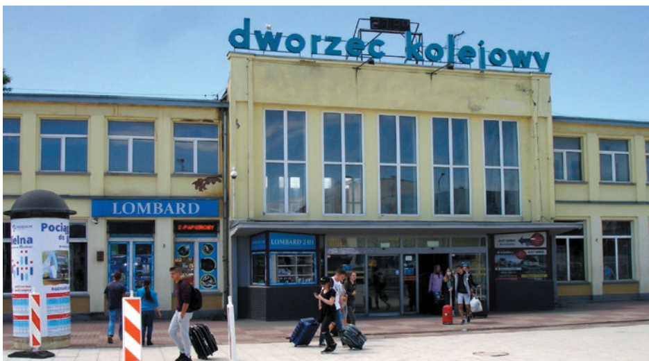
Zupełnie nowy dworzec kolejowy w Koszalinie zastąpi w końcu 2023 roku wysłużony budynek, który powstał w powojennej Polsce.
