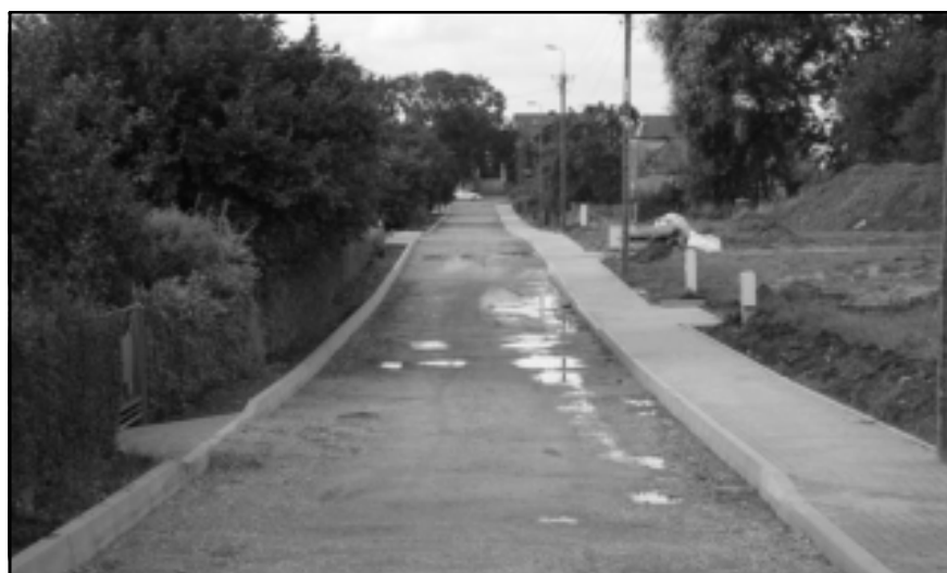
Budowa ulicy Ogrodowej w Mścicach
