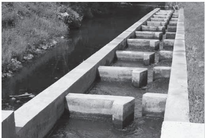
Ryc. 4. Przeplawka w Żarnowie ma charakter techniczny typu Vertical-Slot, szerokość szczelin 20 cm i nadal zapewnia możliwość wędrówek troci wędrownej i lososia.
