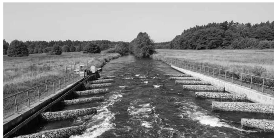
Ryc. 3. Gwiazdowo – przepławka w formie bystrza wykonana na całej szerokości koryta.
