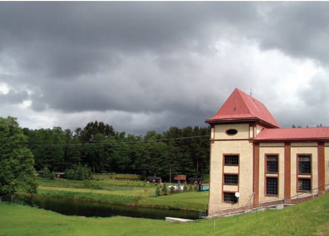
Elektrownia wodna w Rosnowie (fot. D. Józków).
