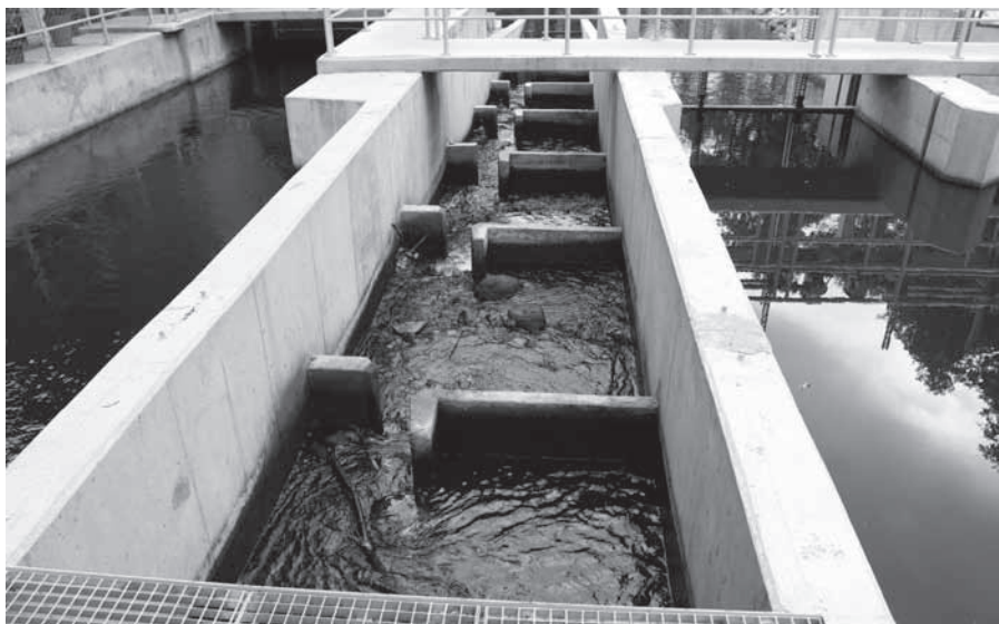
Ryc. 6. Przepławka w Grądzie – przepławka w trakcie częściowego odwodnienia (konserwacji) z widocznymi elementami dna.
