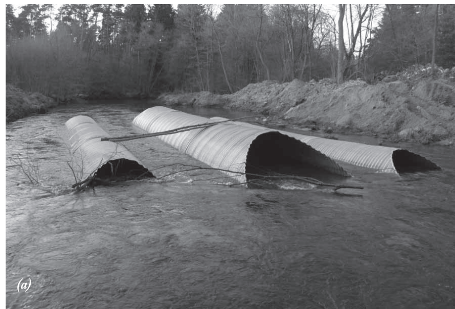
Ryc. 5. Osówka - konstrukcja regulująca przepływ w korycie rzeki Parsęty w km 78+550: (a) etap budowy i (b) etap eksploatacji.
