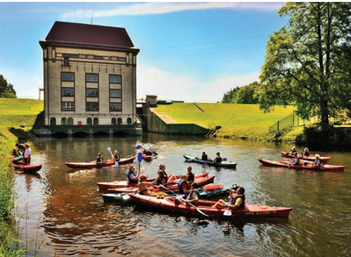
Elektrownia wodna w Niedalinie (fot. W. Kosowski).
