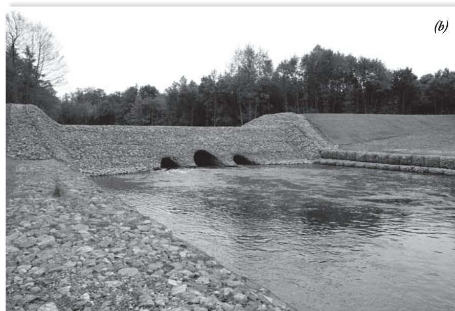
Ryc. 5. Osówka - konstrukcja regulująca przepływ w korycie rzeki Parsęty w km 78+550: (a) etap budowy i (b) etap eksploatacji.
