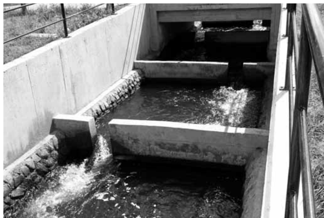
Ryc. 2. Fragment przepławki na węźle w Pomiłowie w formie bystrza betonowo-kamiennego o trapezowym przekroju koryta.
