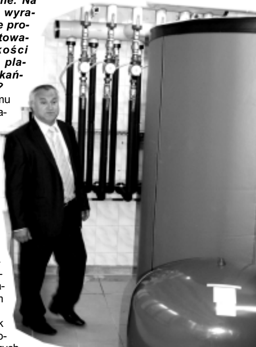
Uruchomienie pomp ciepła w DPS Żydowo
