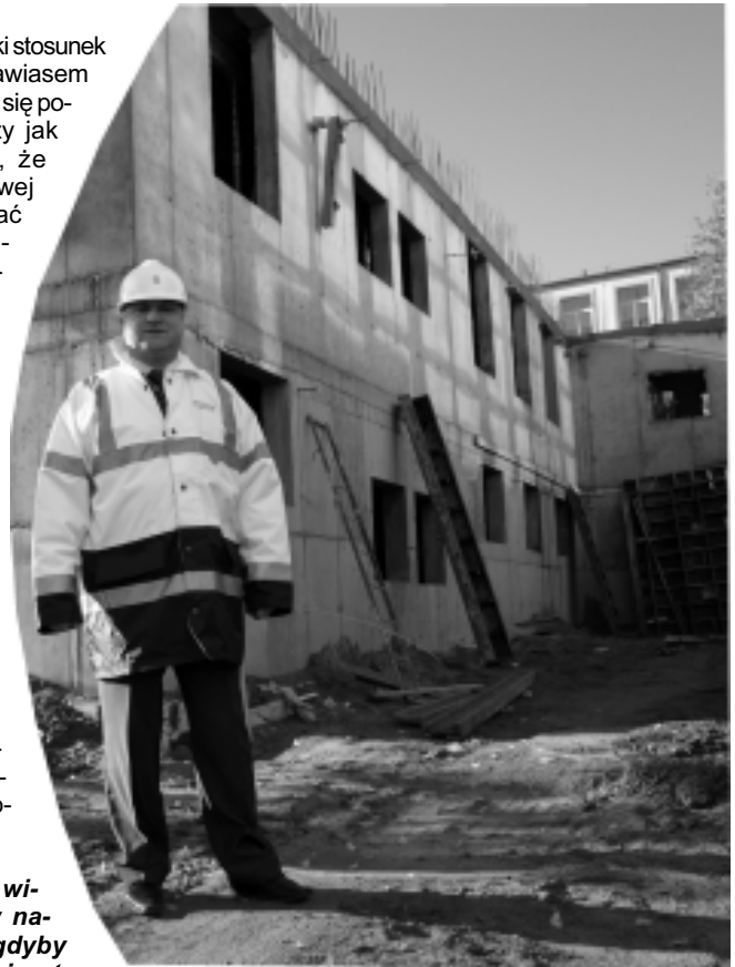
Starosta na placu budowy PUP
