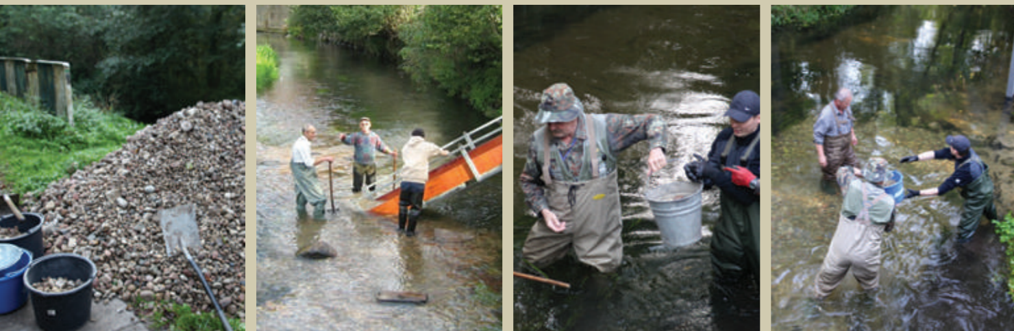
1. Substrat tarłowy. / 2,3,4. Wykładanie substratu tarłowego w rzece.
