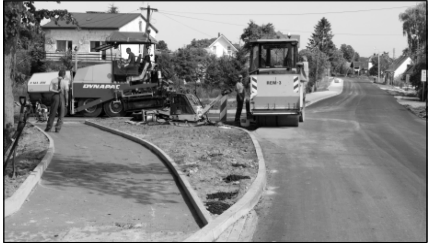
Prace na drodze w Dobrem
