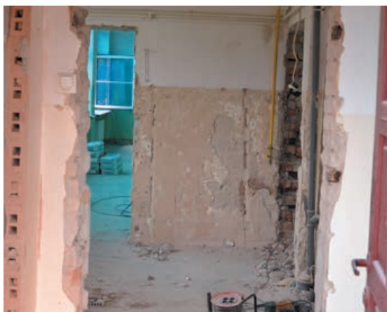
Przebudowa szkoły w Świeszynie
