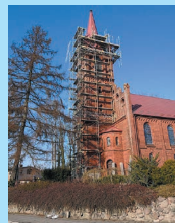
Rozpoczęto remont wieży kościoła
