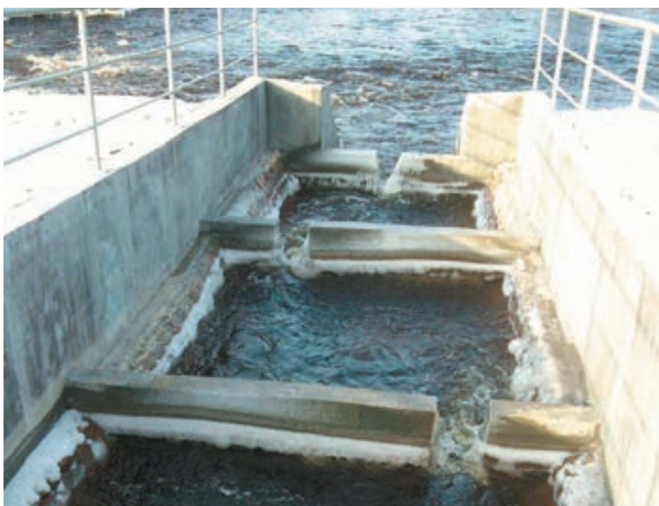
Przełławka szczelinowa na Wieprzy w Pomiłowie.
