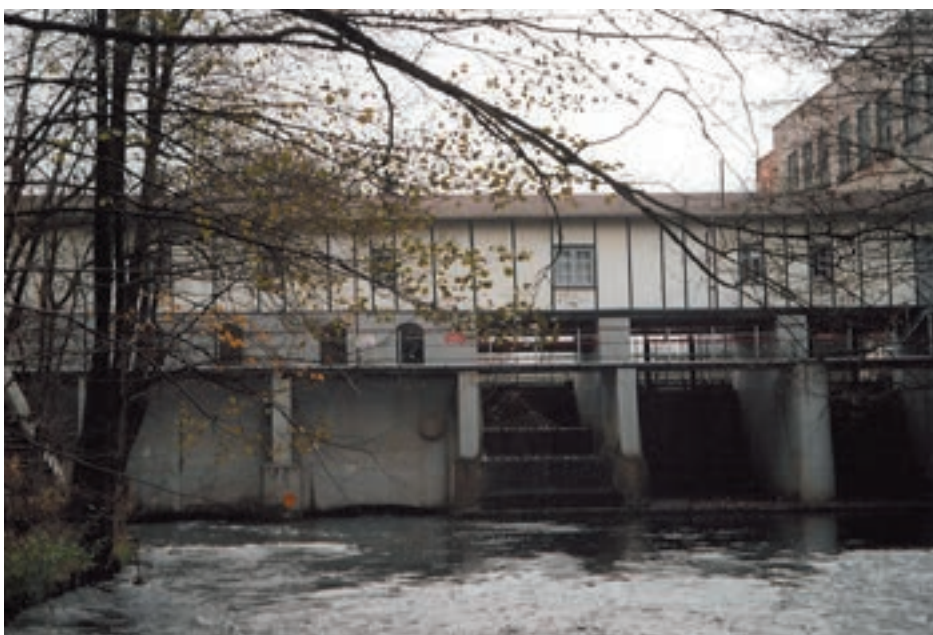
Elektrownia wodna w Kępicach na Wieprzy bez przepławki dla ryb.
