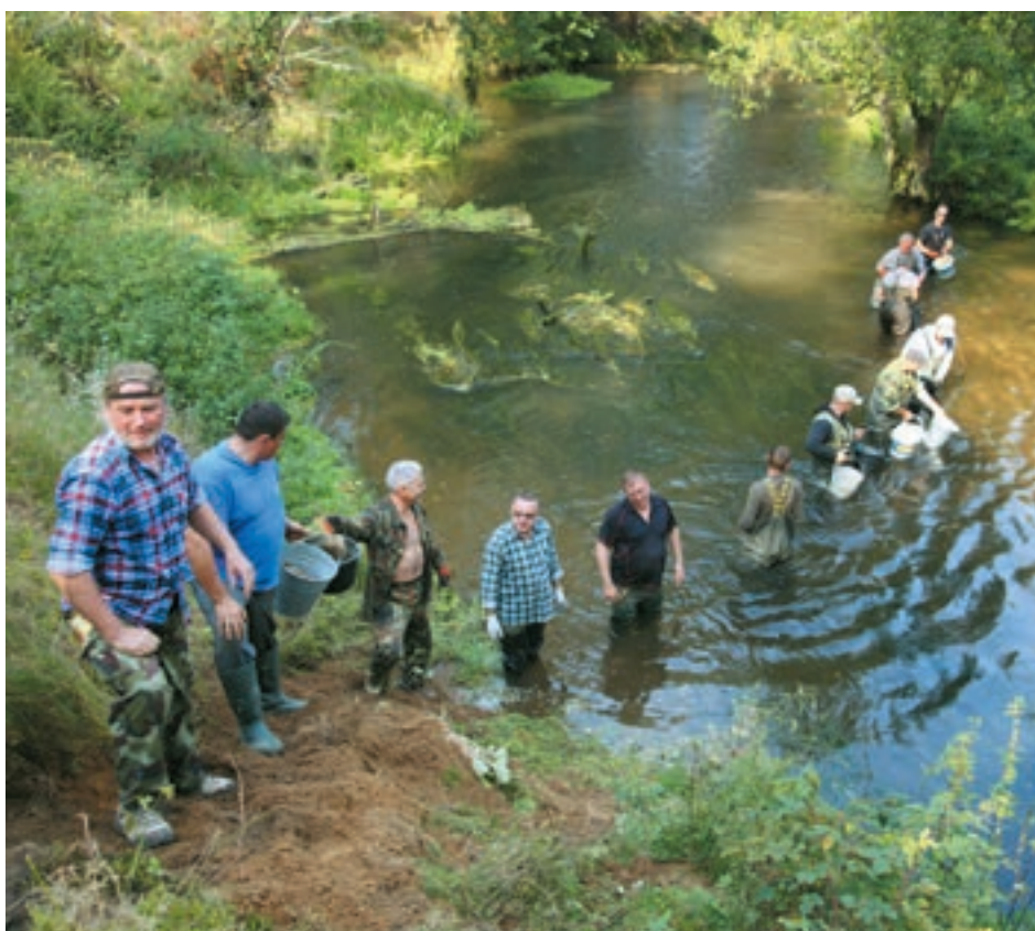
Czynny udział wędkarzy w budowie sztucznego tarliska.
