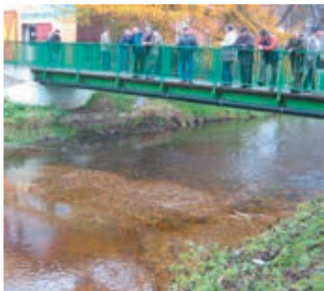
Budowa i wygląd sztucznego tarliska w Kanale Miejskim rzeki Wieprzy w Sławnie.
