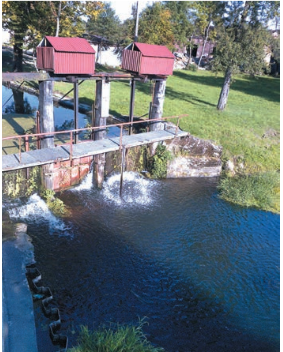
Piętrzenie wody dla małej elektrowni wodnej w Karlinie.
