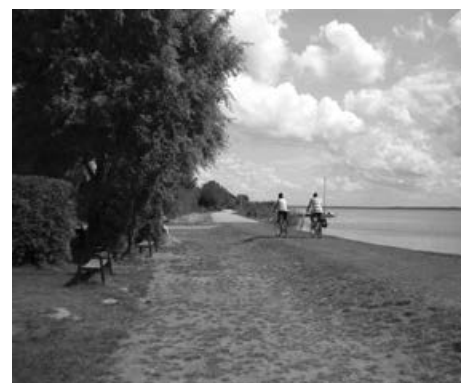
Wał przeciwpowodziowy na Jamnie.
