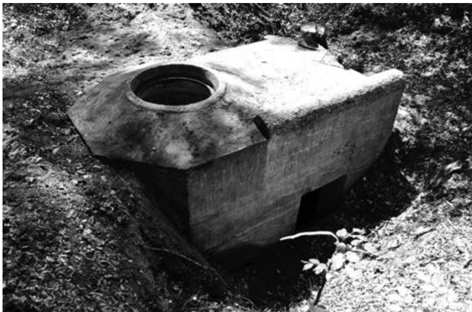
Oficjalna prezentacja uporządkowanego schronu miała miejsce w pierwszy weekend lipca 2016 r. To właśnie wtedy przy obiekcie spotkali się m.in. członkowie działających na terenie powiatu koszalińskiego grup rekonstrukcyjnych.
