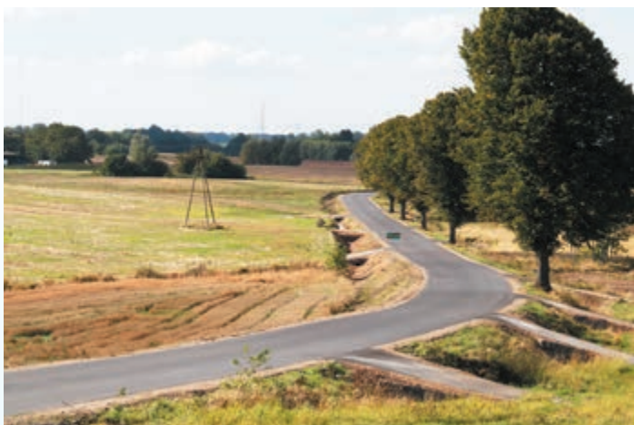
Przebudowane drogi powiatowe nr 3327Z od granicy powiatu (Rusowo) przez Strzepowo do Dobrzycy i 3341Z ze Strachomina do granicy powiatu (Skoczów) o długości 7,8 km. Wartość inwestycji to 6,829.608 zł.
