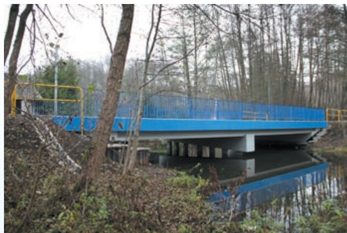
Przebudowany i wyremontowany most w Ubiedrze. Wartość inwestycji to 334.867,50 zł.
