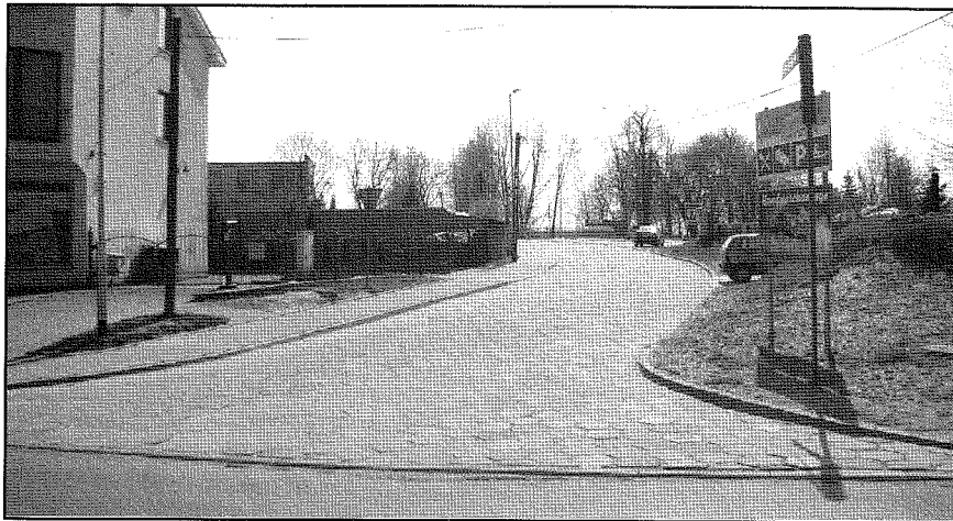
Na zdjęciu - wyremontowany odcinek ulicy Przemysłowej Fot. K. Szpakiewicz
