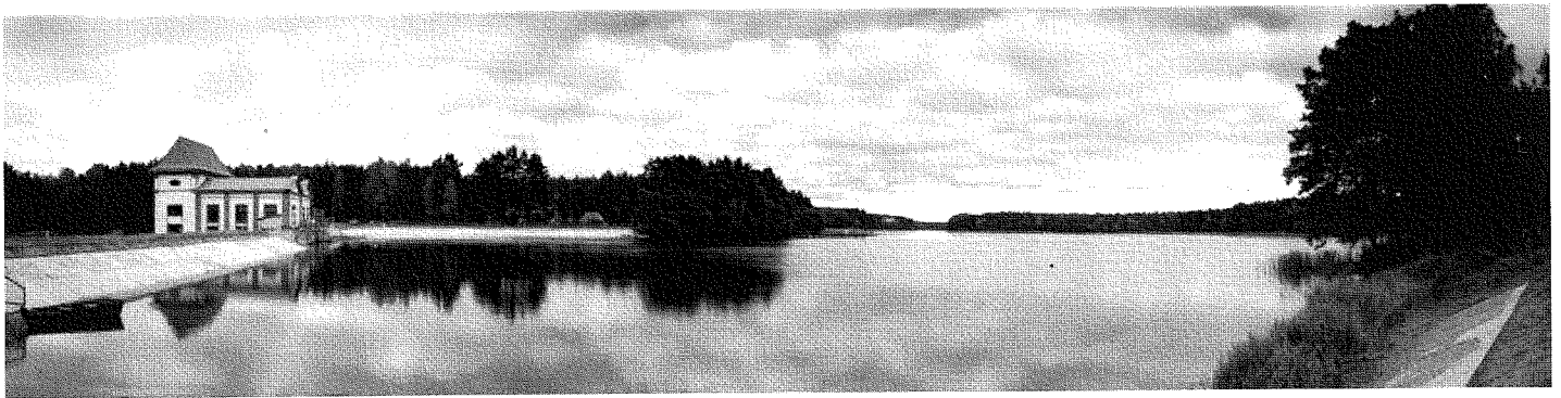
Niedalino - elektrownia wodna
