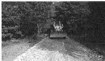
Remont drogi Konikowo-Giezkowo
