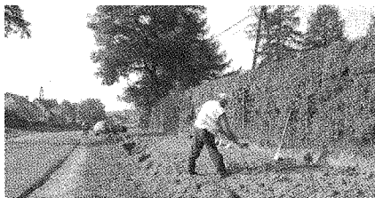
Przygotowanie terenu pod budowę chodnika w Giezkowie
