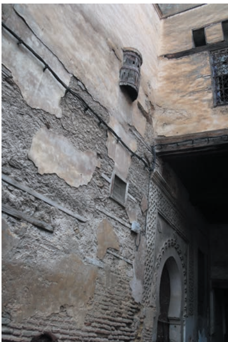
Ściana domu z umieszczonym wysoko oknem.
